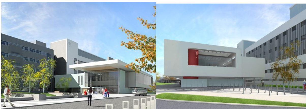
Figur 1: Frontbygget på nye AHUS (kilde: www.nyeahus.no )
